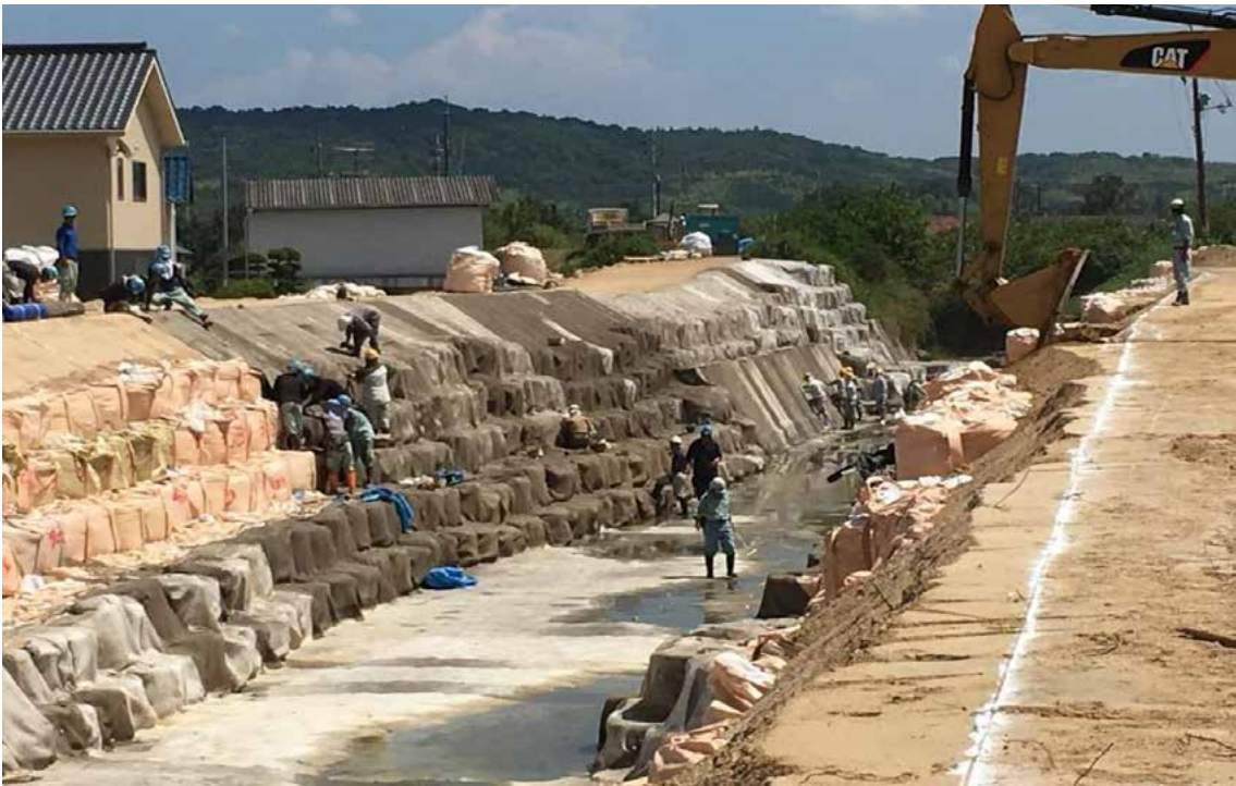
西日本豪雨 阪 末政川堤防決壊応急復旧（岡山県真備町）
