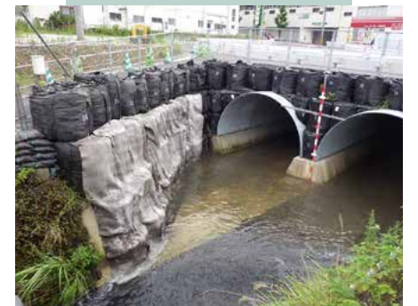
大型土のう被覆工
