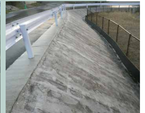
法面保護工・防草工・鳥獣掘起し対策工
